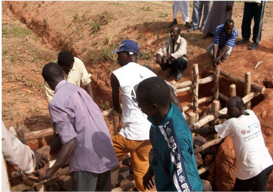
Fig. 7: Construction d'un bac à cadres
