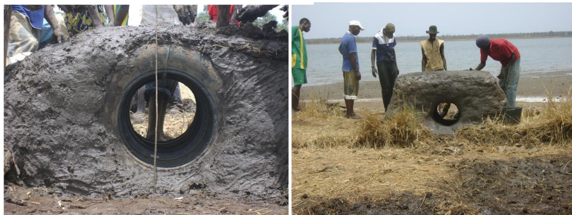
Fig 6: Utilisation de pneus usagés pour la construction d'une prise de courant
