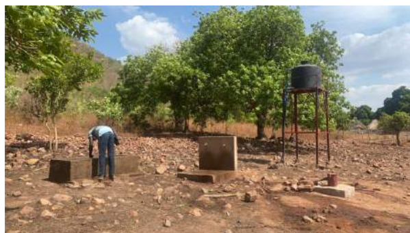
Photo 3: Equipement collectif dans les emprises du projet (Borne Fontaine/abreuvoir/réservoir)
