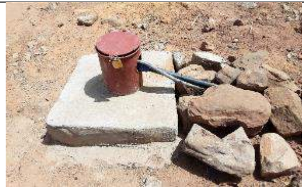
Forage à la sortie de Ségou
