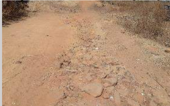
Dépôts solides sur la chaussée (X - 12.289261 ; Y 12.409238)
