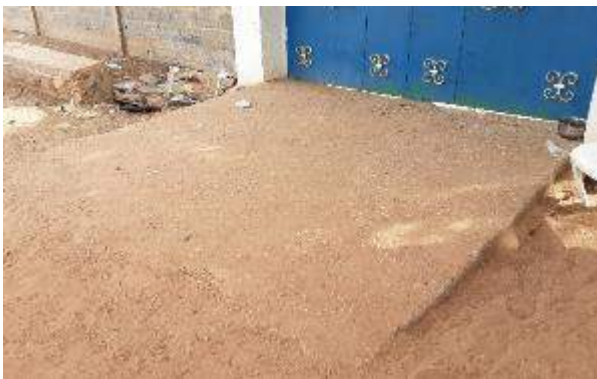
Rampe d'accès d'une maison à Mbeuleukhé
