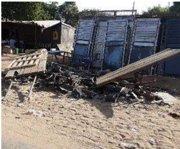
Atelier menuiserie métallique à Dahra
