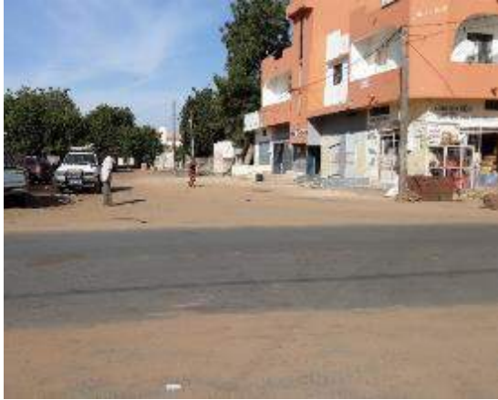
Bâtiment en dur à Dahra
