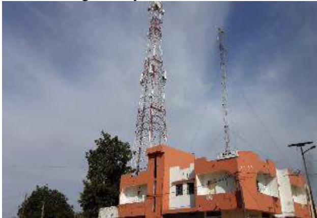
Antenne de Télécommunication
