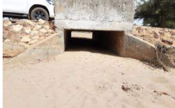
Photo 17 : Dalots identifiés sur l'emprise de la Bretelle de Yang-Yang (Source: HPR-ANKH, 26 Novembre 2021)
