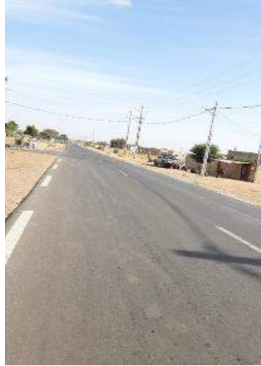
Emprise du tronçon à Dahra
