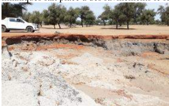
Photo 16: Ravinements observés dans la zone restreinte du tronçon Bretelle de Yang-Yang (Source: HPR-ANKH, 26 Novembre 2021)
