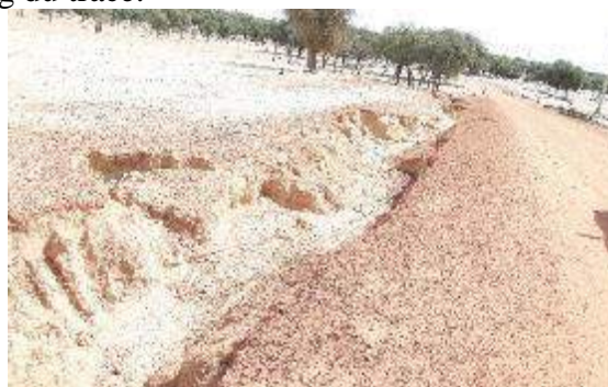
Photo 16: Ravinements observés dans la zone restreinte du tronçon Bretelle de Yang-Yang (Source: HPR-ANKH, 26 Novembre 2021)
